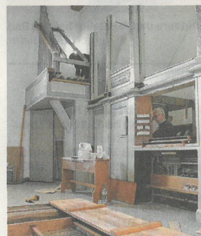
Das Orgel-Gehäuse ist gestern schon zu großen Teilen entkernt.
